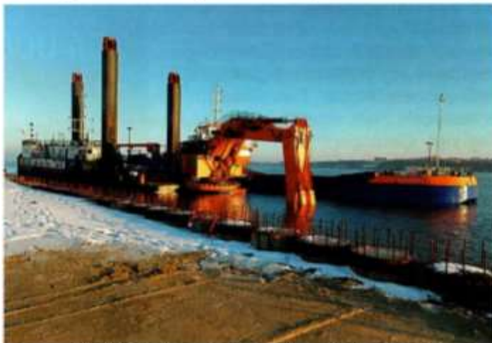
Nach Wiederaufnahme der Arbeiten 2022
