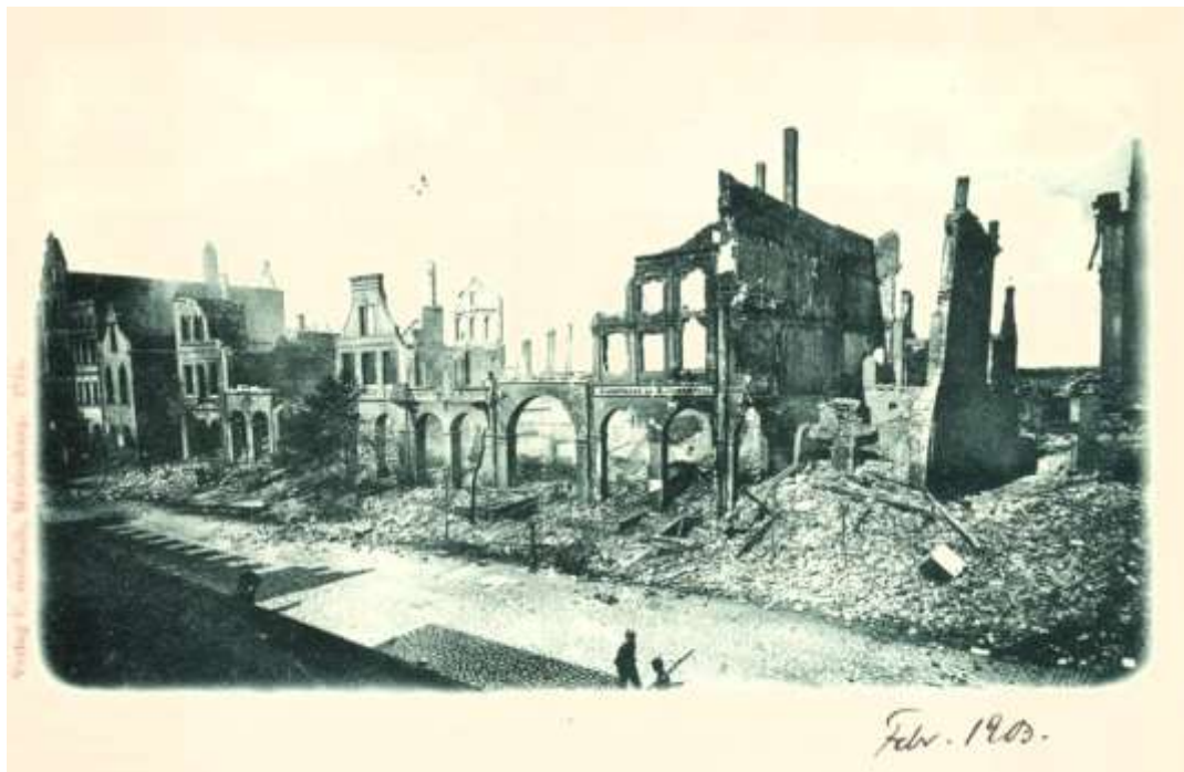
Foto 3: Blick auf die Lauben nach dem Brand 16
