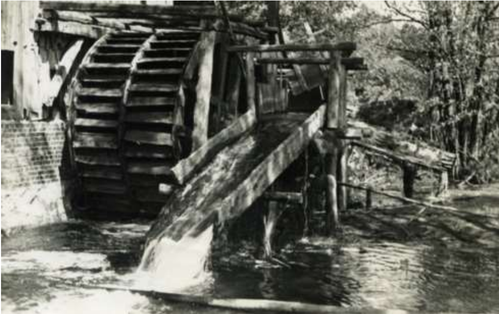
Görlitz, Wassermühle am Grießlerfließ
