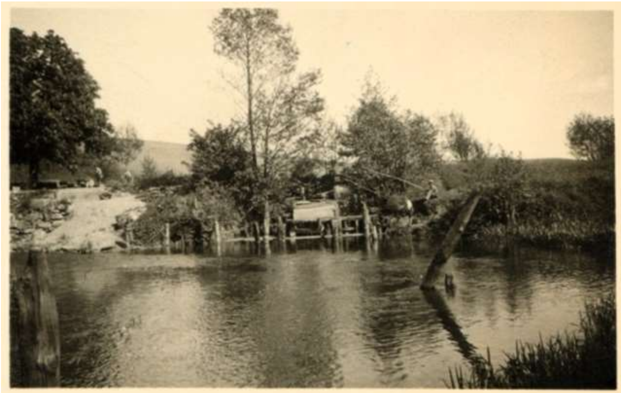
Bei der Hirschbergmühle
