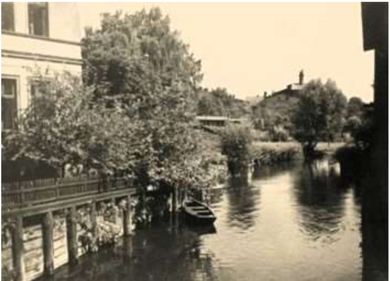
Blick von der Drewenzbrücke in der Baderstraße zur Brauerei
