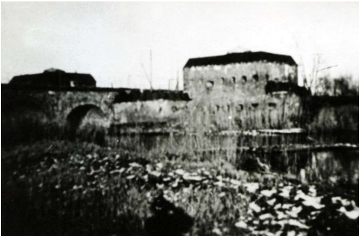
Bergfriede, Befestigungsanlage mit Brücke an der Drewenz
