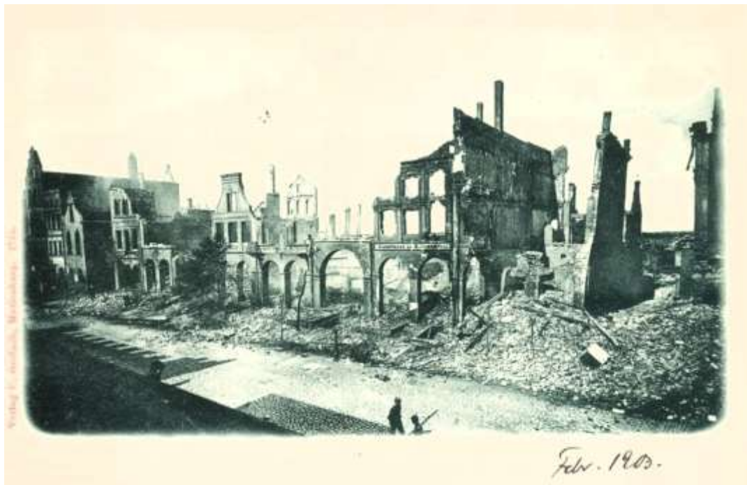
Foto 3: Blick auf die Lauben nach dem Brand 16
