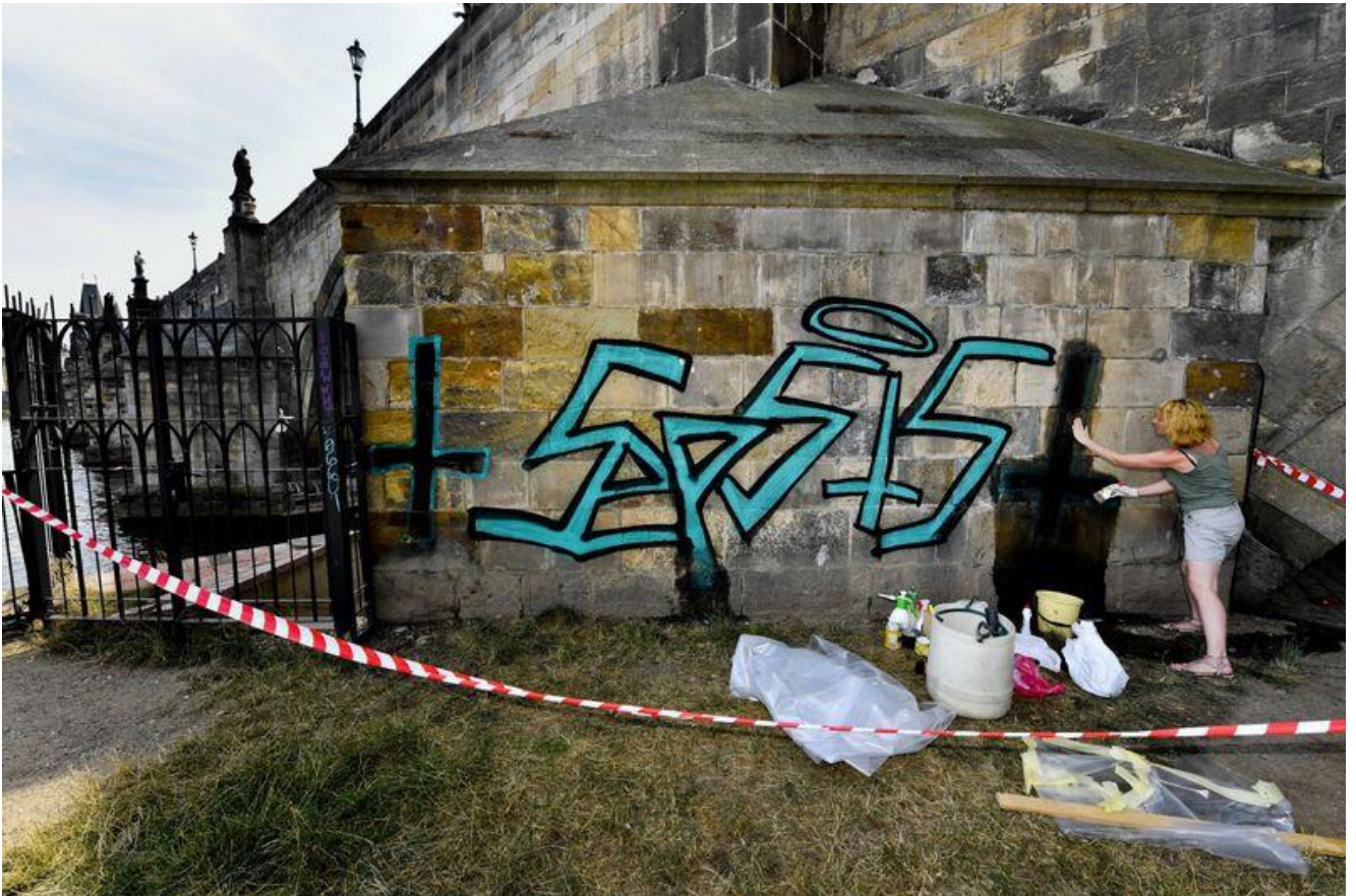
Brückenpfeiler der Karlsbrücke mit einem Graffiti (Foto: ČTK / Vít Šimánek)
