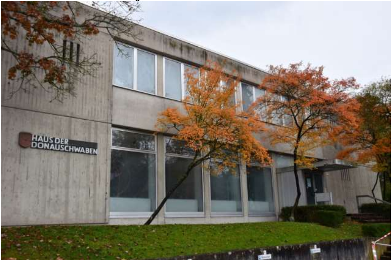
Das Haus der Donauschwaben in Sindelfingen bei Stuttgart ist gleichzeitig Begegnungsstätte, Museum und Archiv
