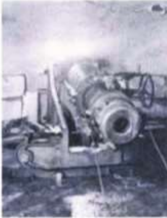
Moderne 12-cm-Minimal-schartenkanone M.96. Mit einer Schußweite von rund 6.500 m galt die Kanone als Fernkampfgeschütz und gelangte in gepanzerten Kasematten zum Einbau.
