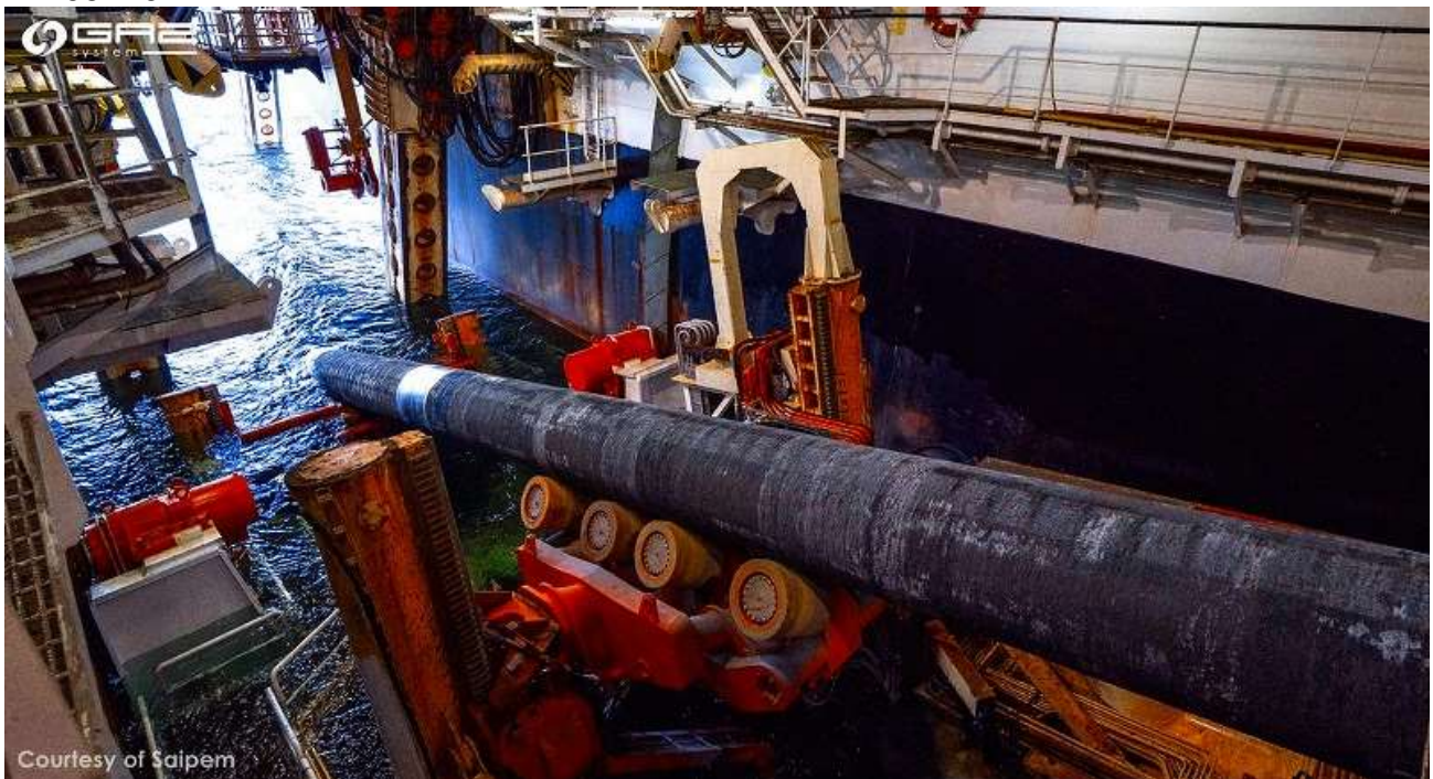
Baltic Pipe-Gasleitung im Bau · Bildquelle: Saipem-Gaz-System
