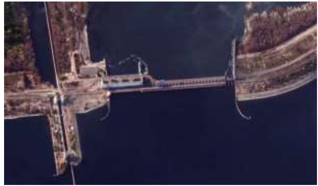
Teile der nördlichen Ausdehnung des Damms und der Schleusentore wurden beschädigt. (Maxar Technologies / Reuters)
