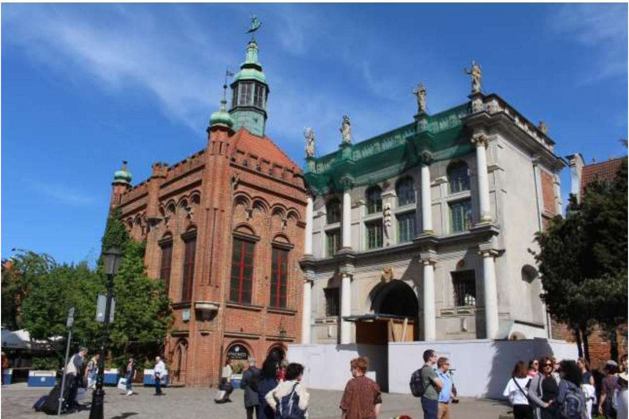
Danzig, Haus der Georgenbruderschaft und Langgasser Tor, Zugang zur Langgasse.- Aufnahme: Reinhard M. W. Hanke, 22.05.2023, IMG 7567.
